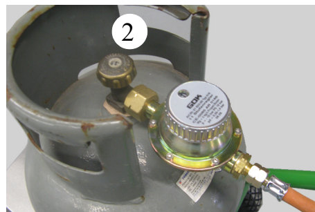
Fig. 5-16: Gaskraan sluiten
